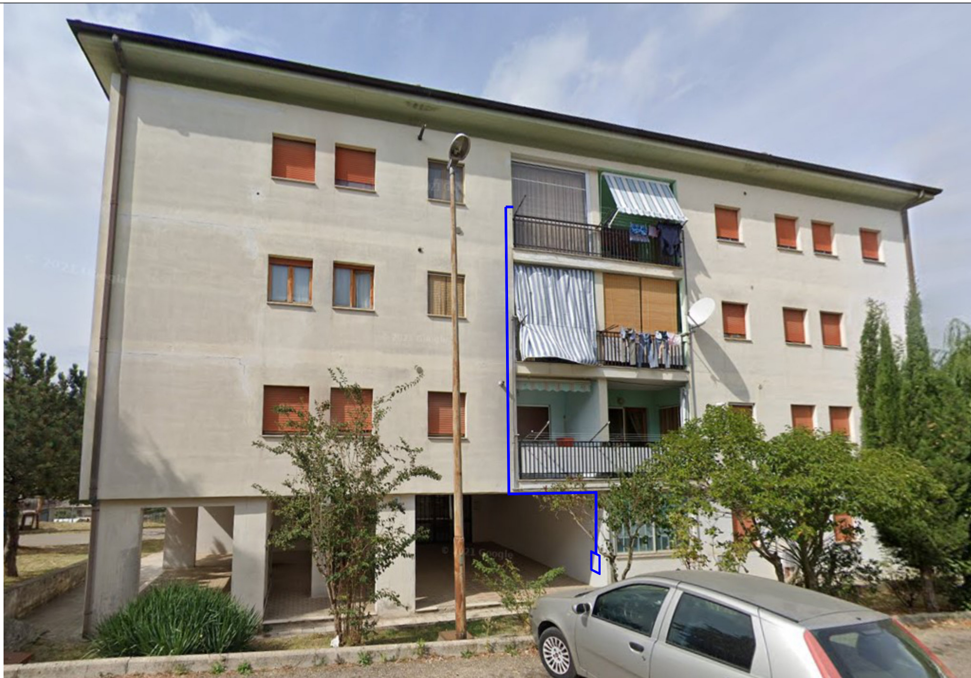
Foto n.9 - Prospetto EST - Linea fornitura gas metano da realizzare con posizionamento della cassetta di alloggiamento del misuratore
